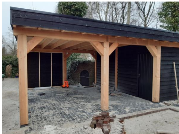
Foto 2 Carport voor de ingang naar de tunnel
