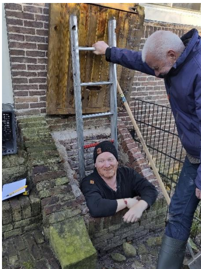
Foto 2 Waterkelder Dikninge: mangat
